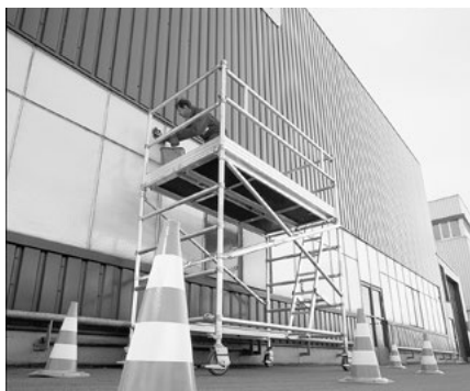
Kennzeichnung des Arbeitsbereiches einer Arbeitsbühne (Sicherungsmaßnahme gegen Anfahren)
