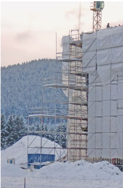
Gerüstvorbau zum Absetzen von Lasten
