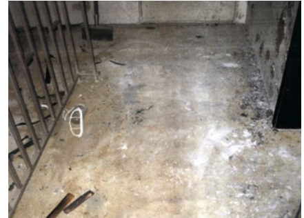
Ein durch ein Stahlwerkzeug erzeugter Funke löste die Explosion des Aceton-Luft-Gemisches mit verheerenden Folgen aus
