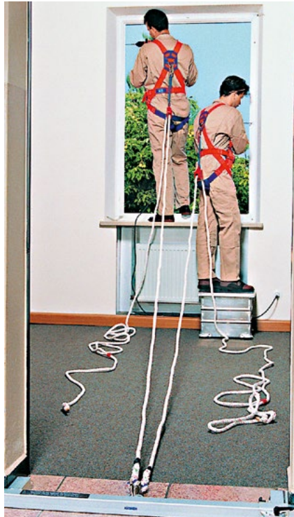
Fenstermontage mit PSAgA
