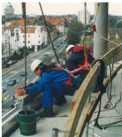
Montage von Fenster-/Fassadenelementen bei einer Absturzhöhe von mehr als 2 m.
