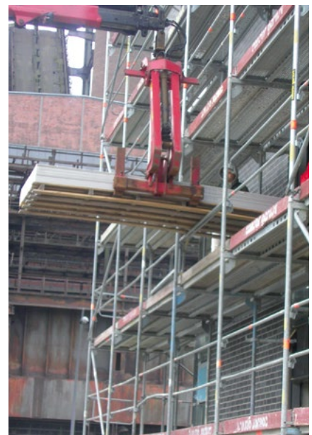
Materialtransport mit LKW-Ladekran
